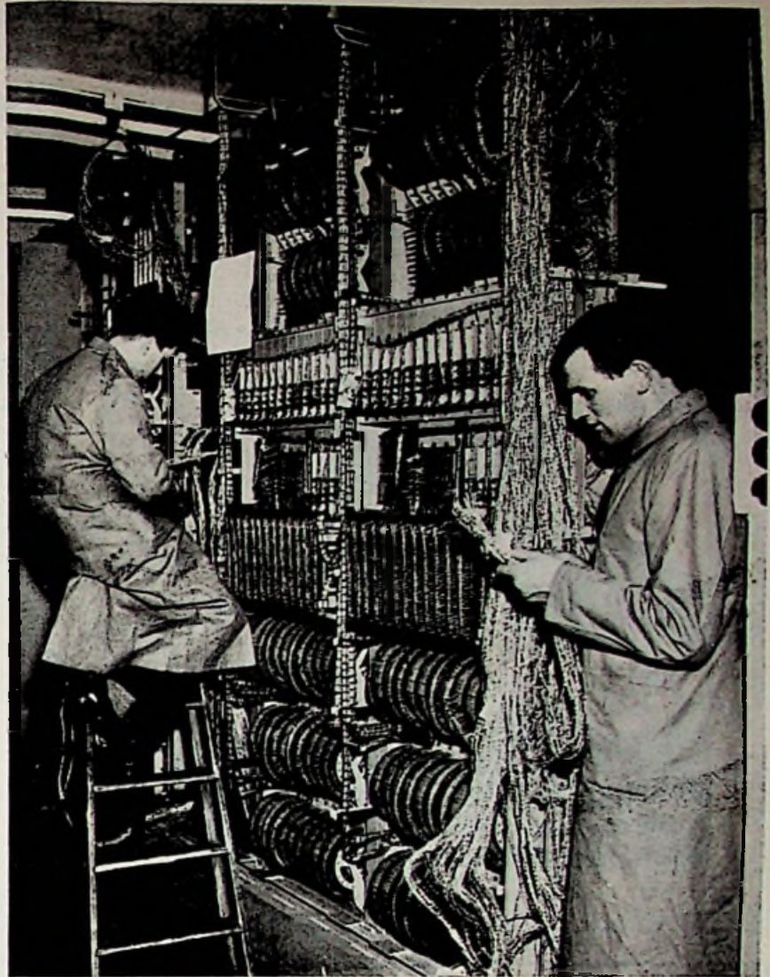
De opbouw van de telecommunicatie-afdeling vereist veel werk. Men ziet hier monteurs bezig met de bedrading van een kies-installatie
